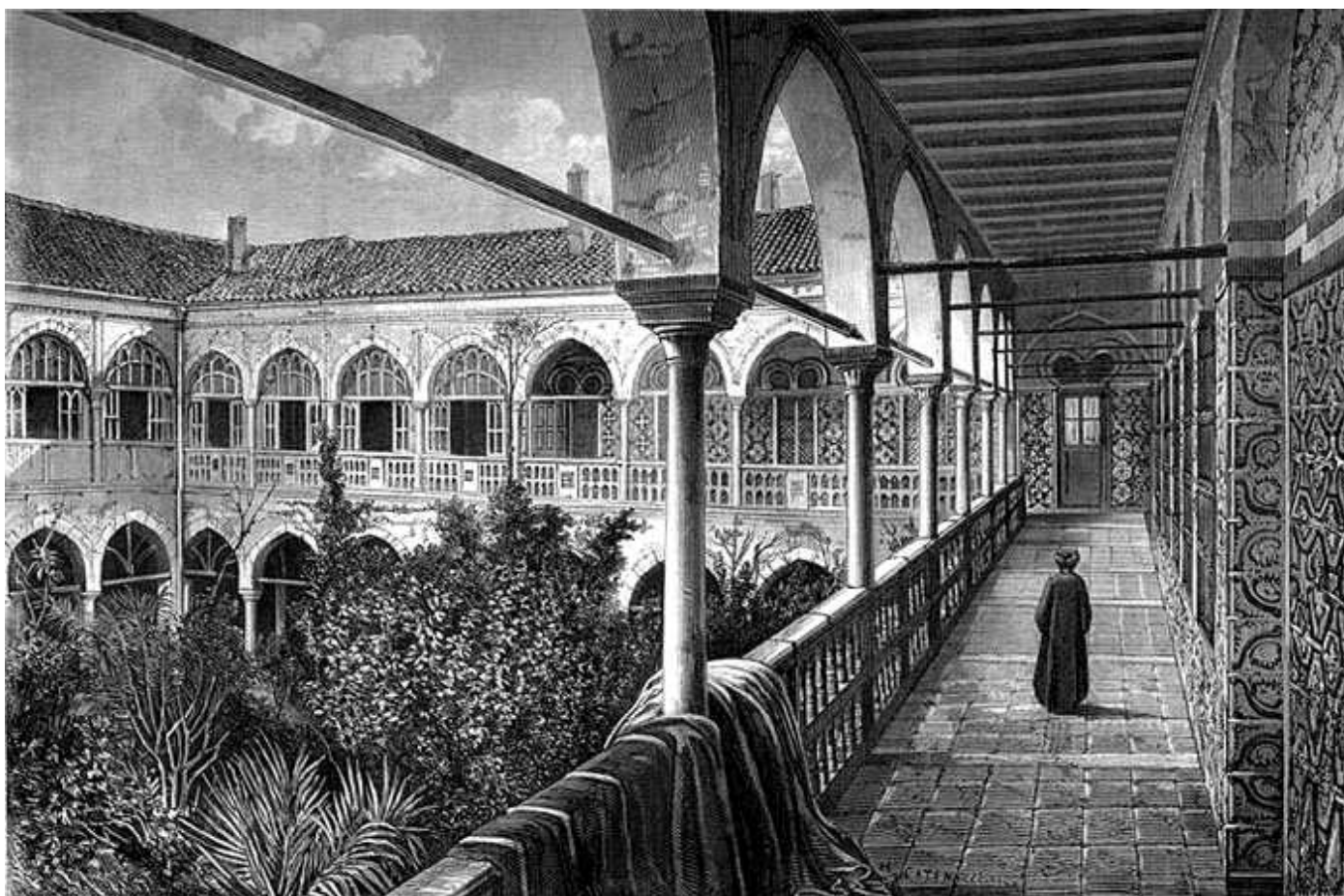
Galerie supérieure des appartements autour du jardin des orangers.
