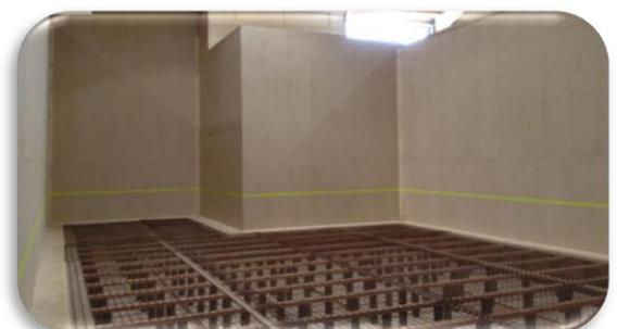
Cellule de séchage avec caillebotis en treillis métallique et parois recouvertes en OSB
