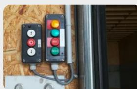
Interrupteur permettant de mettre en route le séchoir en façade
