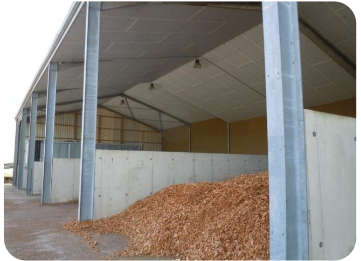
Exemple d'aménagement de cellule de séchage à plat
