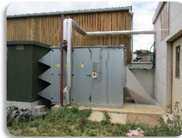
Batterie chaude et ventilateur
