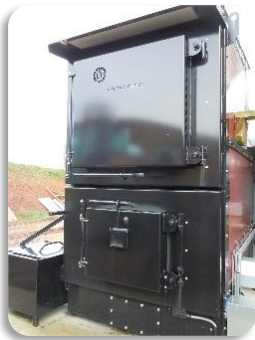
Générateur d'air chaud au bois déchiqueté
